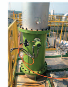
バグフィルター出口 ダストモニタ
