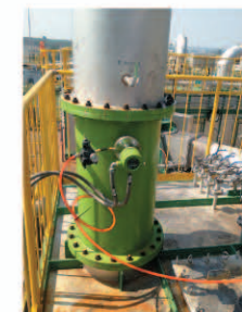
バグフィルター出口 ダストモニタ
