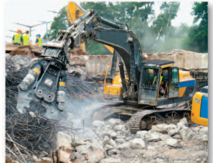
工事・解体現場
